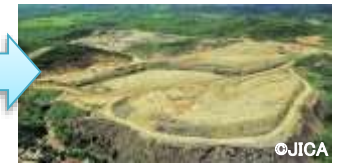
覆土によるごみの飛散・流出を防止
