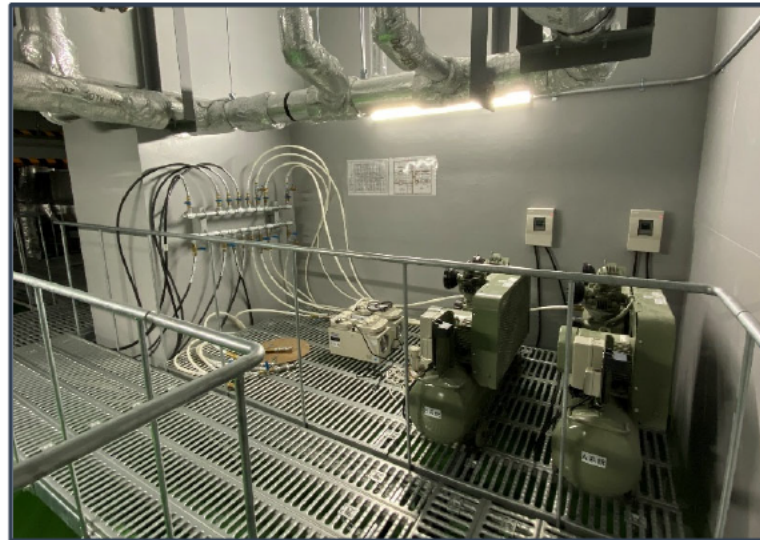
気密性試験実施に係る機材などの実施体制構築 (加減圧用コンプレッサー×2台・減圧用ポンプ×2台・ヘッダー)
