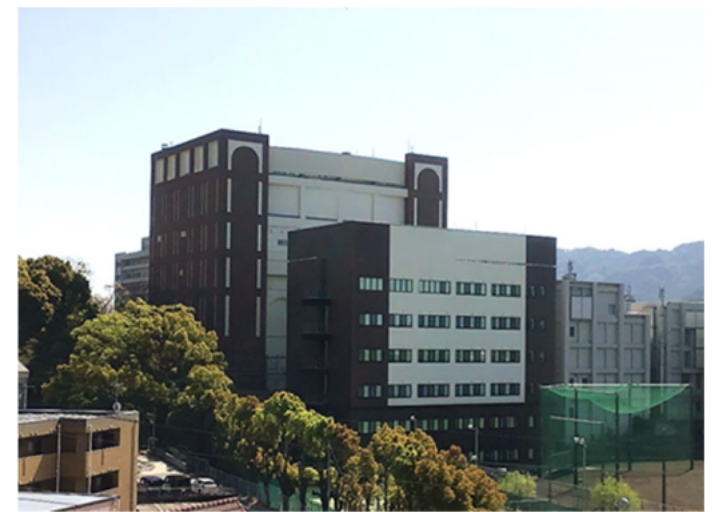
高度感染症研究センター実験棟（奥）、同本館（手前）
