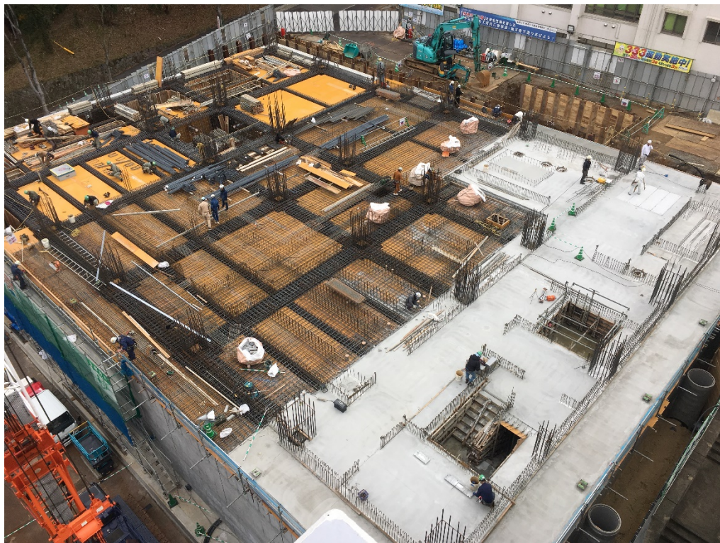
施工状況全景(1/6撮影)
