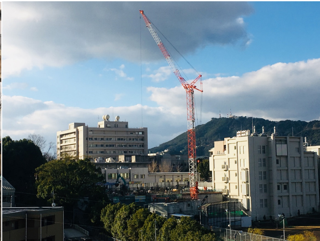
施工状況全景(1/6撮影)
