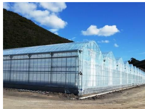
○ハウス外観 高軒高で既存APハウスに比べ、環境の変化が緩やかで制御しやすい
