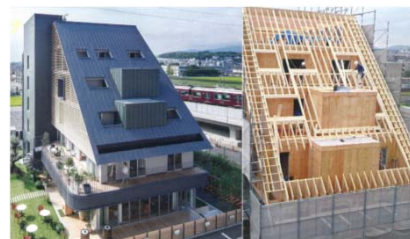
木造非住宅建築物 (※JAS構造材(2×4部材)を活用した商業ビル)
