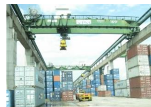
OHBC(天井クレーン)
