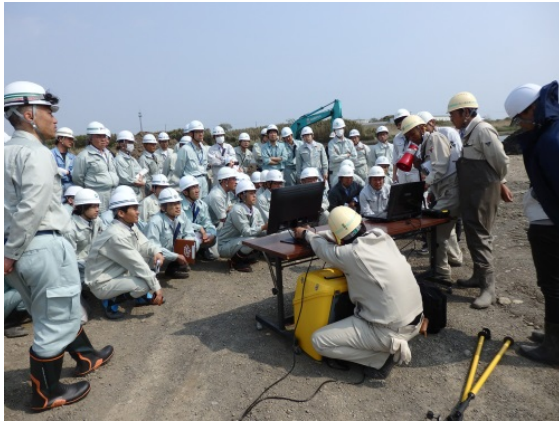
太田川ICT活用工事現場見学会
