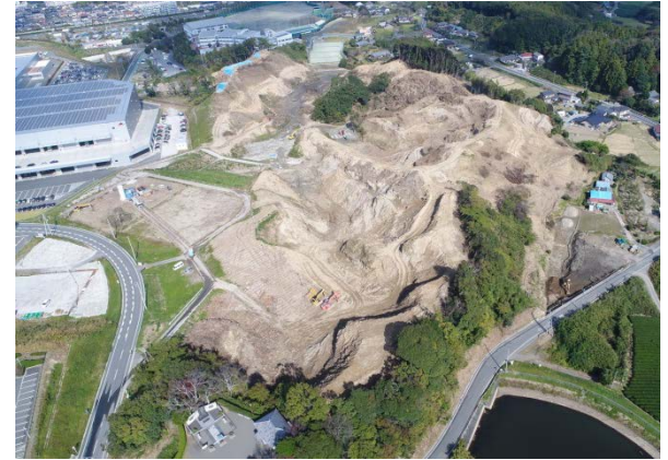
南西郷工業団地造成工事（掛川市・地元施工業者施工）
