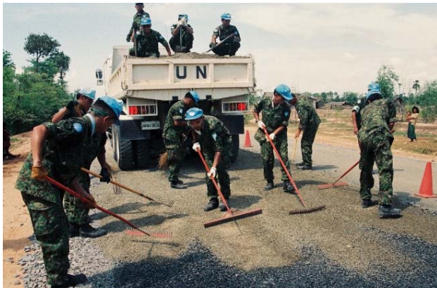
国道3号線の補修作業を行う施設部隊
