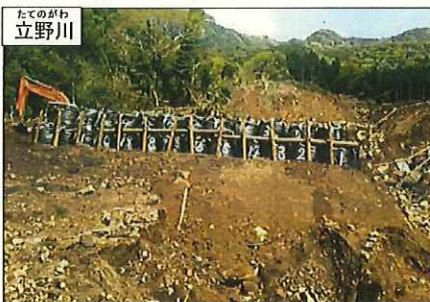
たてのかわ 立野川 大型土のう設置状況(4月22日完了)
