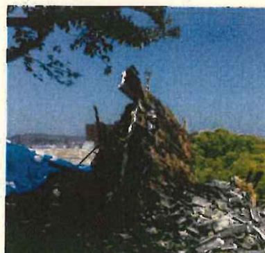
全壊した櫓が石垣下の神社を損傷
