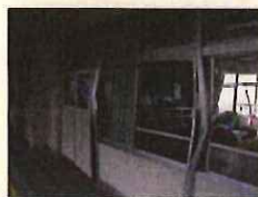
建具が変形し、ガラスが割れる危険性のある廊下（中学校）
