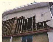
建具が変形し、ガラスが割れる危険性のある廊下（中学校）
